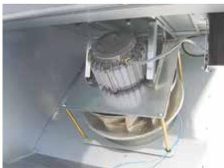
Montagesokkel er tilbehør til VEX140-150-160 og standard på VEX170. Montagesoklen er udstyret med fødder, der har en justerbar højde på 130 - 160 mm.
