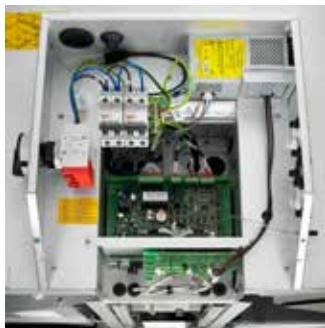
Den let tilgængelige tilslutningsboks med indbygget forsyningsdækskål og automatsikringer sikrer nem adgang for tilslutning og servicering.
